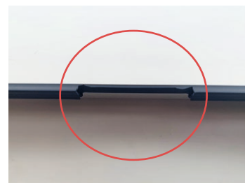
Afbeelding beluchting dmv rubberdichting onderbreking.
