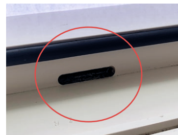
Afbeelding ontwatering sleuf binnenzijde.
