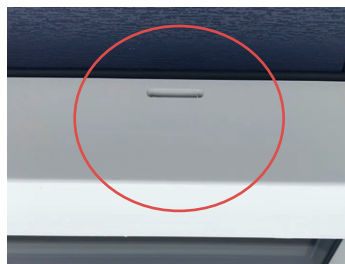
Afbeelding ontwatering sleuf buitenzijde.
